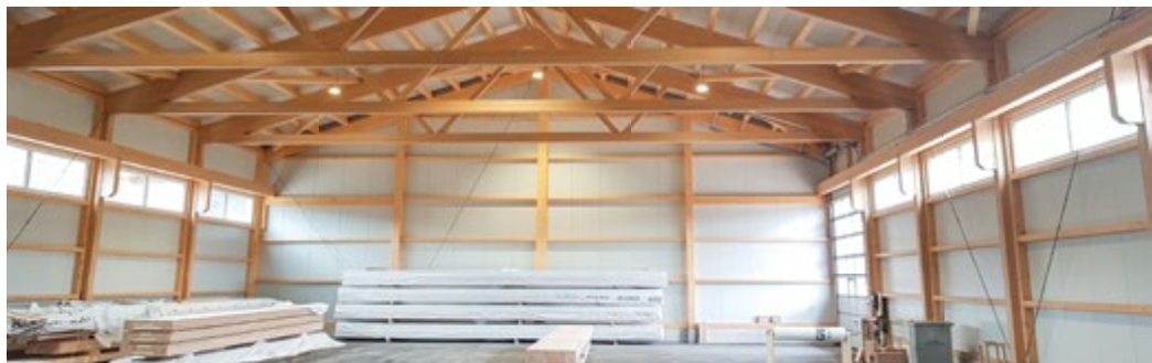
Äusserst schlankes Fachwerk inklusive Kranbahnen aus Hochleistungs-StabBuche in der neu gebauten Fertighalle am Standort Les Breuleux.
