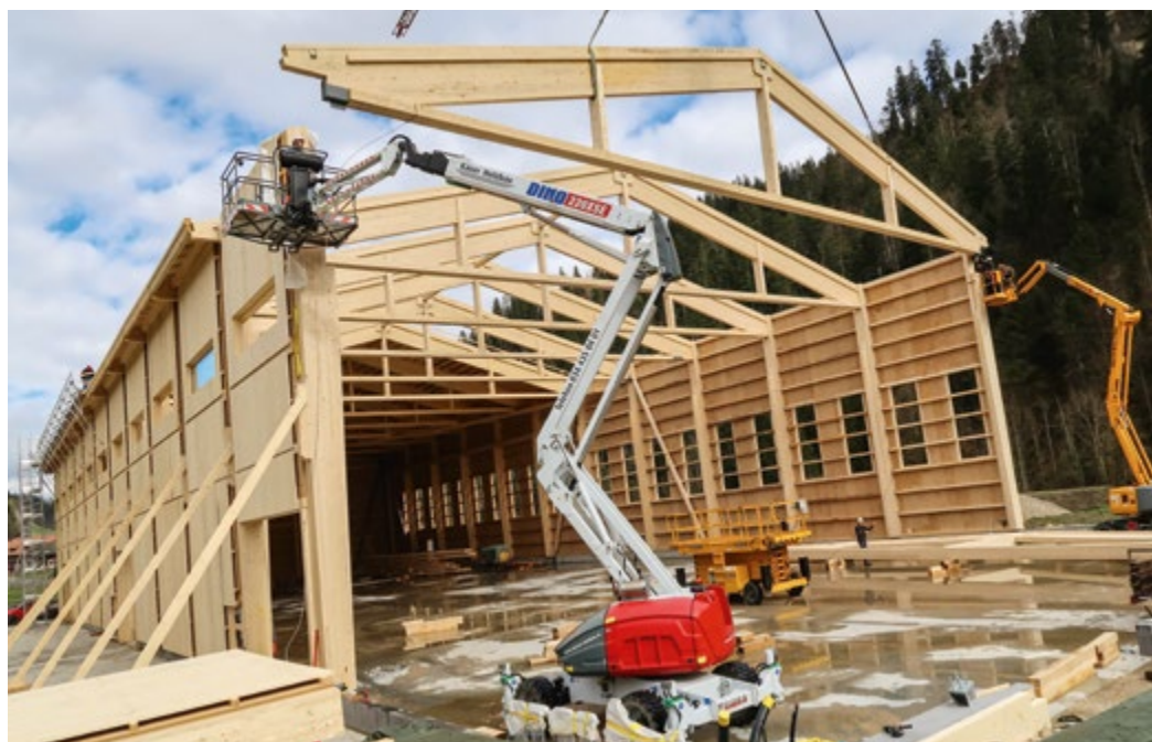
Die Aufrichtearbeiten erfordern Teamwork und Präzision.
