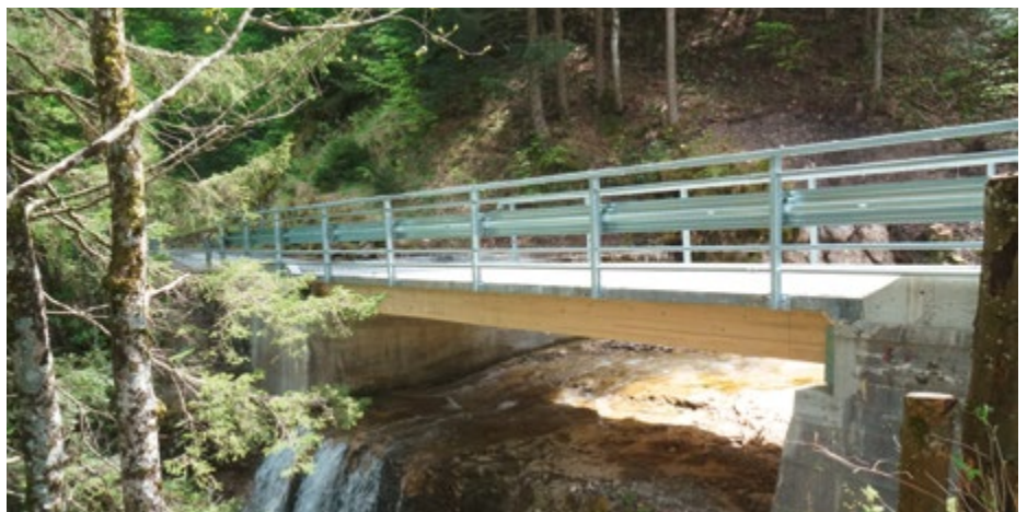
Holz-UHFB-Verbundbrücke Rigi Fruttli
