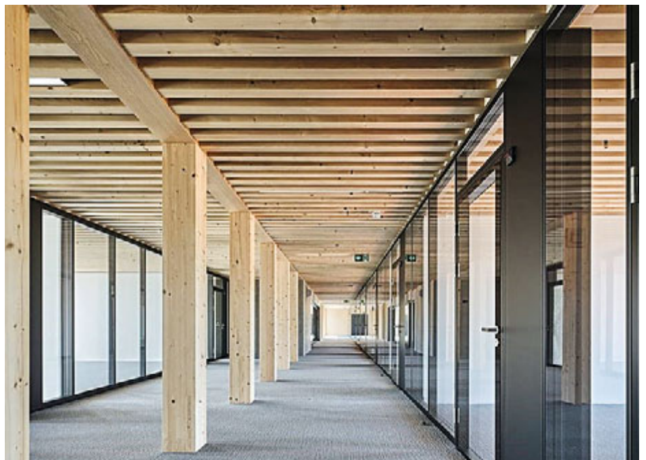
Innenraum des fünfgeschossigen Verwaltungsgebäudes MAD 3 © Roger Frei
