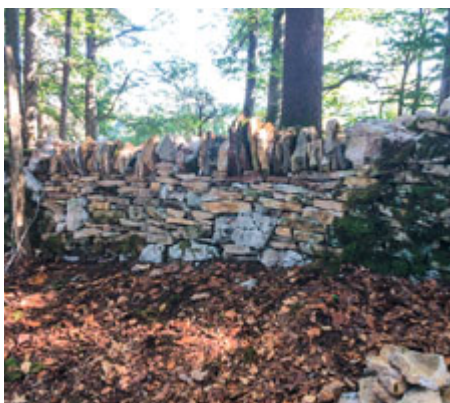
Les travaux sont terminés
