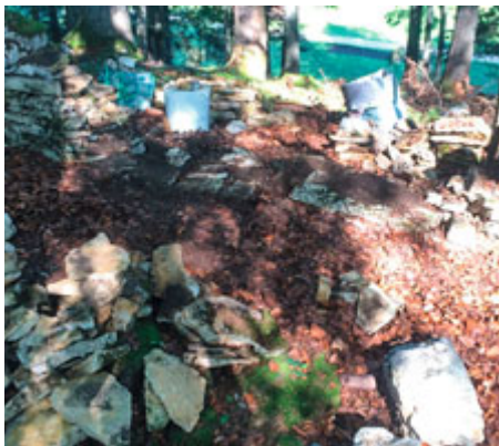
Pose des fondations après le démontage et le tri des pierres
