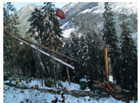
Kombiseilgerät im Bergabbetrieb mit Doppelaufwagen
