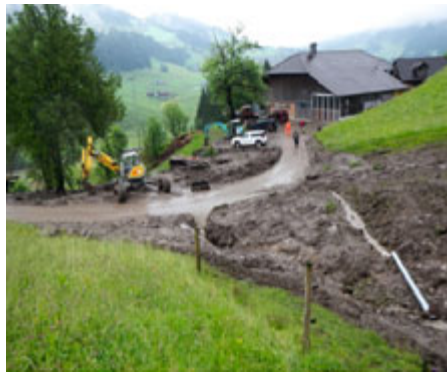
Abbildung 5: Verklausung des Durchlasses bei der Zufahrt Studweidli durch den murgängähnlichen Abfluss am 03.06.2017, Blick in Fließrichtung.
