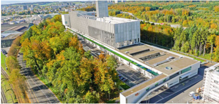
Bild Energiezentrale Forsthaus Bern
