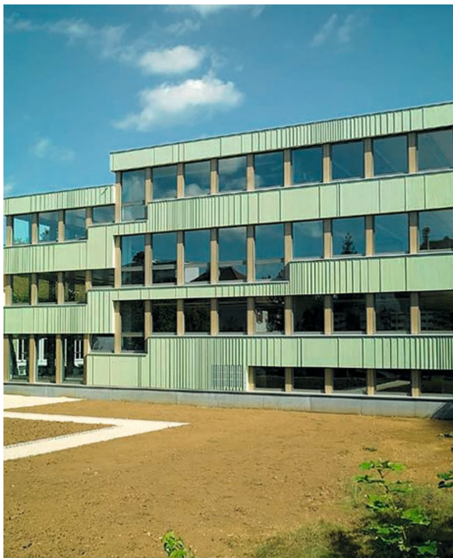
Extension en bois Collège Delémont Source: Pierre Montavon (Tirée dans une fiche technique bois de Lignum consacrée à cet objet)
