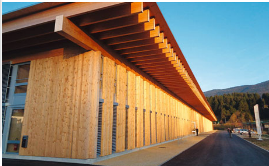
(Nouveau centre d'entretien A16, le bois y a sa place)
