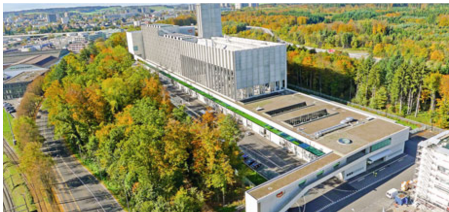
Bild Energiezentrale Forsthaus Bern
