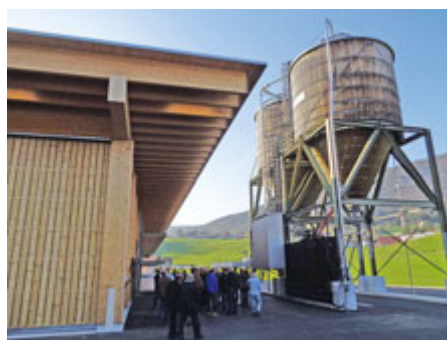
(Cilos à sel au centre d'entretien A16)
