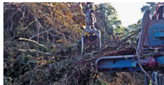
Déchiquetage de bois et de branches
