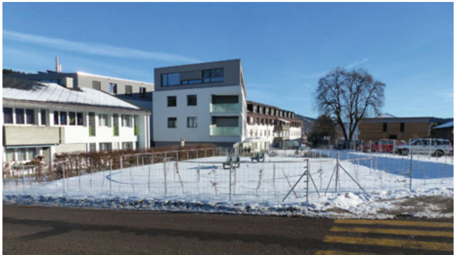
Bâtiments des Lovières chauffés à distance
