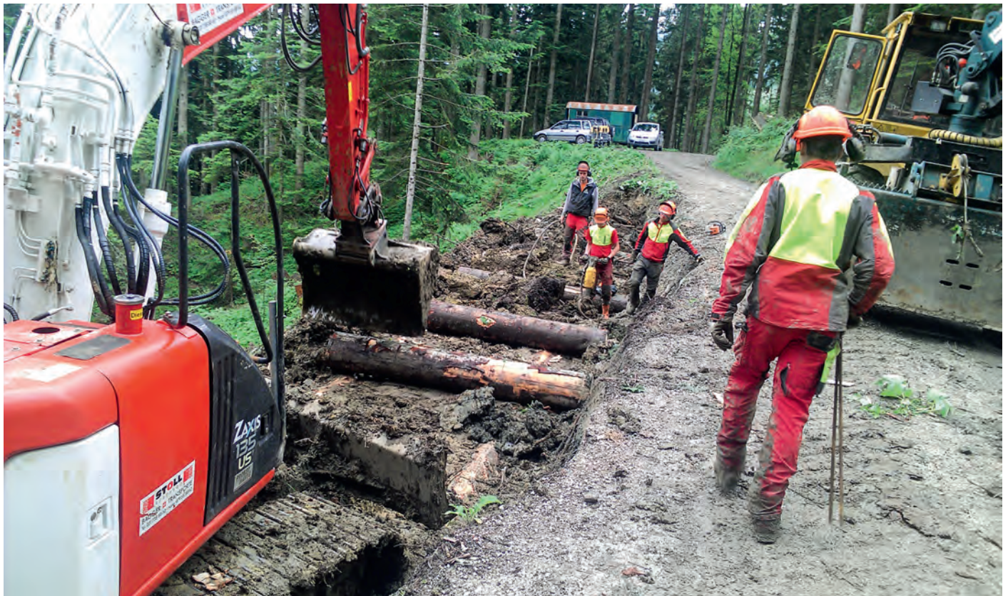
Baukurs E1 Sangernboden, Einbau eines Holzkastens.
