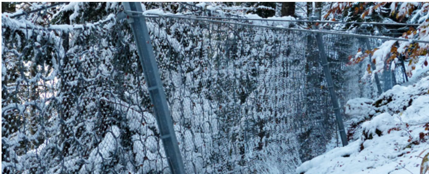
Filet de protection contre les chutes de pierres mis en place en 2008 à l'ouest du funiculaire au-dessus de la route
