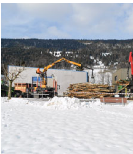
Place de dépôt et déchetage du bois avec la mise des copeaux directement dans le silo du bâtiment de la chaufferie (photo Bühler)
