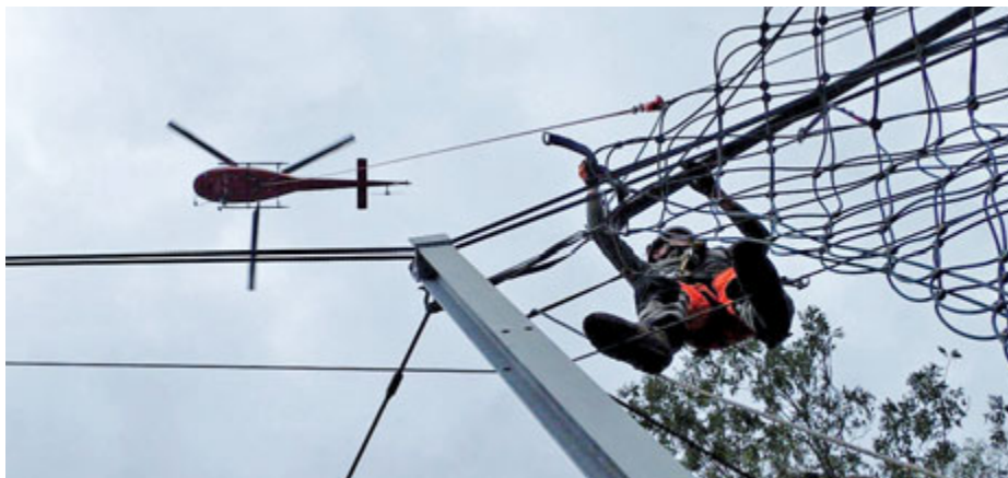
Mise en place du filet de protection à l'aide de l'hélicoptère (Photo D. Linder)
