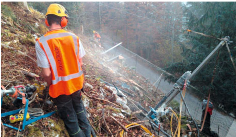
Machine de forage légère avec un faible impact sur la nature pour un diamètre d'ancrage du filet de protection de 90 mm. (Photo D. Linder)
