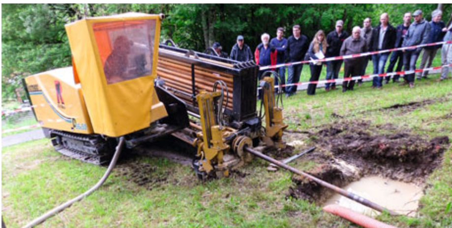
Foreuse horizontale en action pour la mise en place de tuyau de chauffage en passant en-dessous d'un bâtiment
