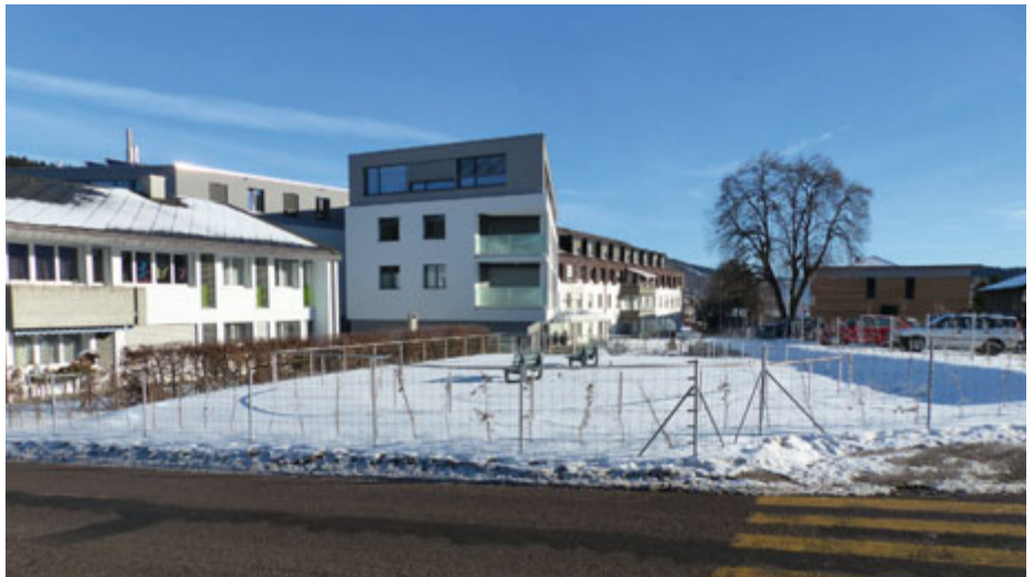
Bâtiments des Lovières chauffés à distance
