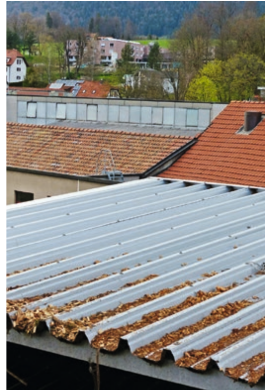
Au premier plan le silo à copeaux de bois qui alimente le chauffage à distance de RU-Calor SA à Reconvilier, avec en haut de la photo, le home La Colline récemment relié à cette centrale de chauffe
