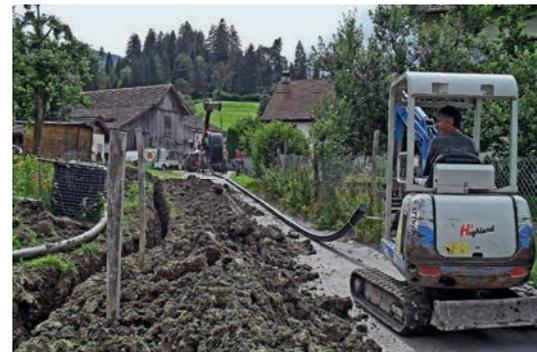
Mise en place d'un tuyau pour le chauffage à distance de Sorvilier (Photo Henri Burkhalter)
