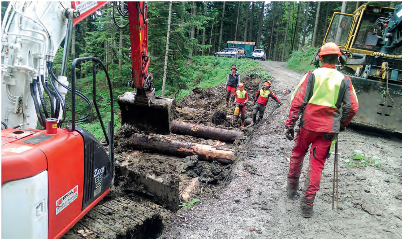
Baukurs E1 Sangernboden, Einbau eines Holzkastens.
