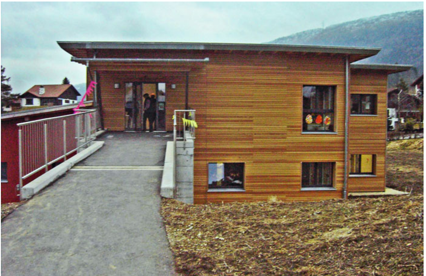
Maison de l'enfance de Malleray chauffée à partir de l'installation de chauffage central à distance à copeaux de la halle de gymnastique.
