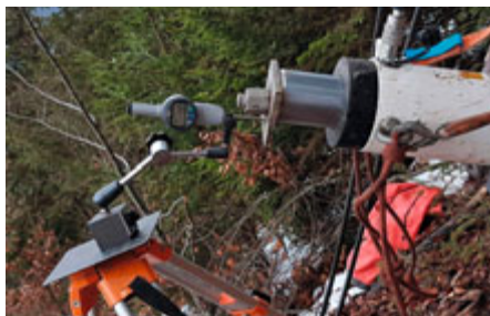
Essai de traction pour contrôler la solidité, le dimensionnement et la qualité de l'ancrage (Photo D. Linder)
