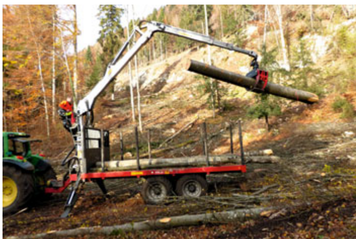
Travaux de défrichage pour le nouveau réservoir réalisé par l'équipe forestière de la Commune bourgeoise de St-Imier
