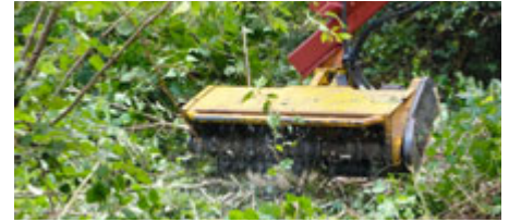
Débroussaillage des buissons tout en préservant le sol
