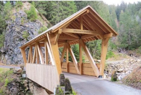
Die 1939 als Symbol für die Wiederaufforstung erbaute Höllbachbrücke im Plasselbschlund wurde 2013 durch Brandstiftung zerstört. Heute verbindet die beiden Talseiten ein Fachwerkbau aus Schweizer Holz mit einem Dach aus 37'000 Schindeln, rund 20 Fahrminuten vom Ort entfernt. Die Brücke dient vor allem der sorgfältigen Nutzung des Rohstoffes Holz.
