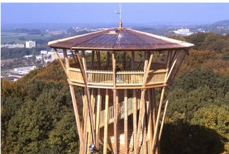
Un double escalier hélicoïdal formé de 151 poutres en Douglas mène à une plateforme située à 30 mètres qui offre une vue à 360° sur la ville de Lausanne, le Lac Léman, les Alpes vaudoises et savoyardes et le Jura. Les quelques 450 m<sup>3</sup> de bois nécessaire à la construction de cette tour proviennent des forêts de la ville de Lausanne.
