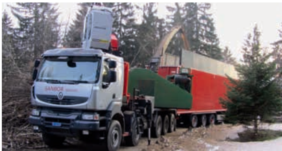
Remplissage d'une benne par la déchiqueteuse
