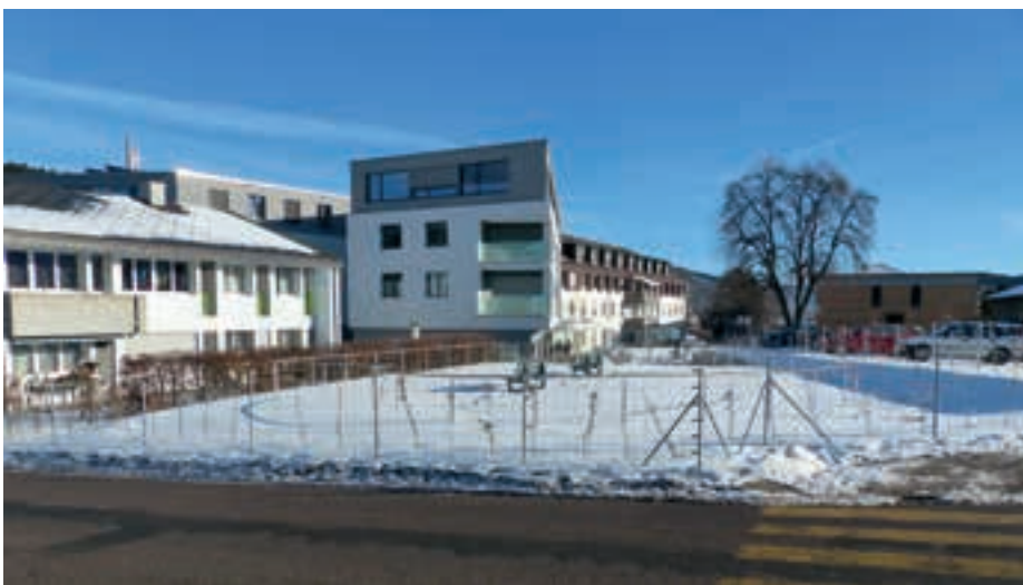
Bâtiments des Lovières chauffés à distance
