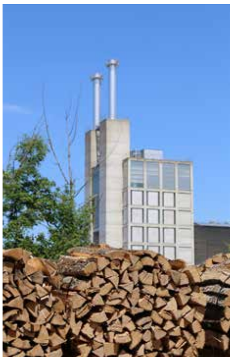
Sichere Energieversorgung dank Holz vom Förster. Foto: Christoph Rutschmann
