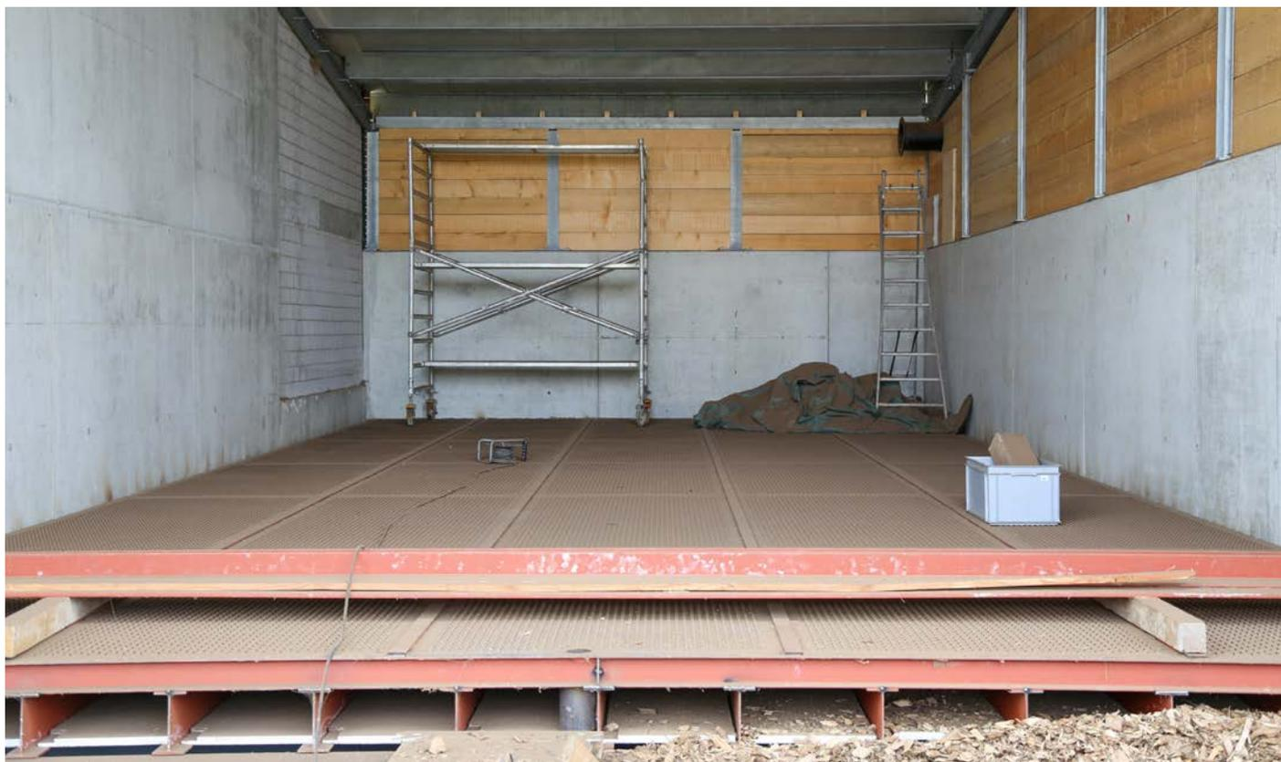
Un double plancher « troué » : l'air chaud insufflé sèche les plaquettes déposées sur la grille
