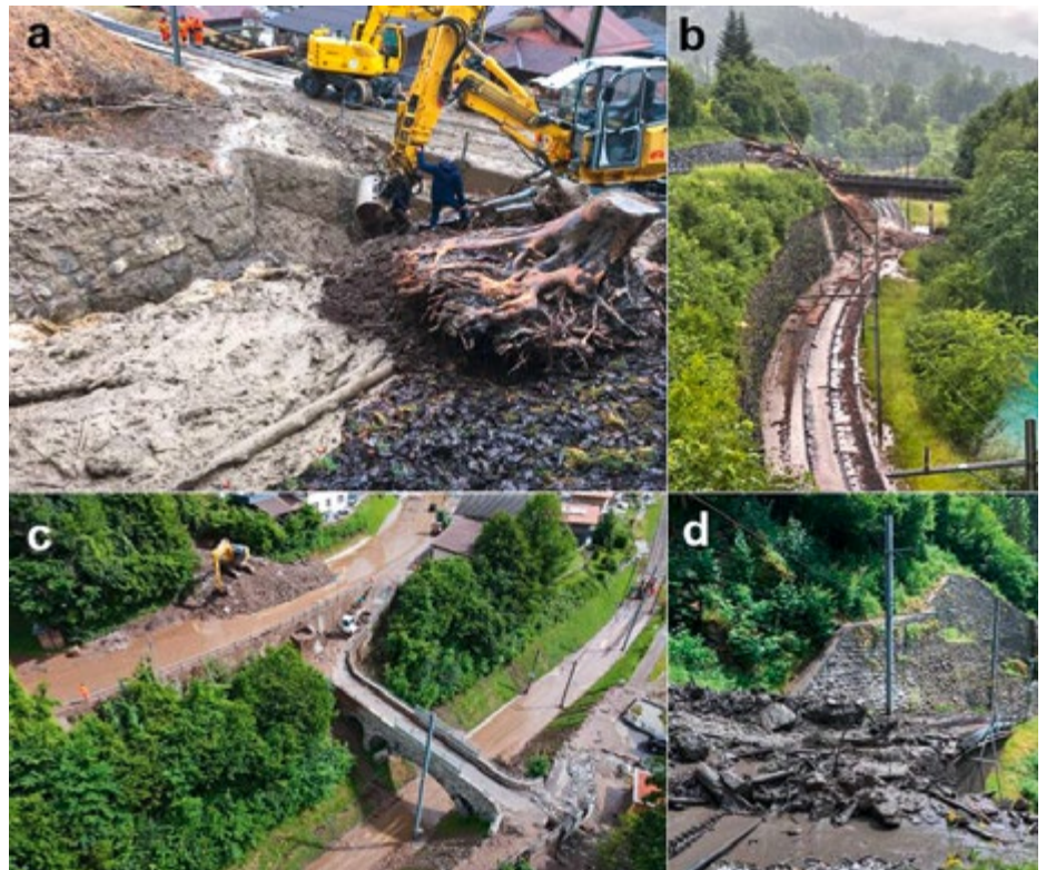
Illustration 5 : Glissements de terrain menaçant des habitations à (a) Signau, photo : S. Bleuler, (b) Oberburg, photo : Ch. Haemmig, (c) Adelboden, photo : N. Hähle et (d) Sigriswil, photo prise par un drone : P. Nescher
