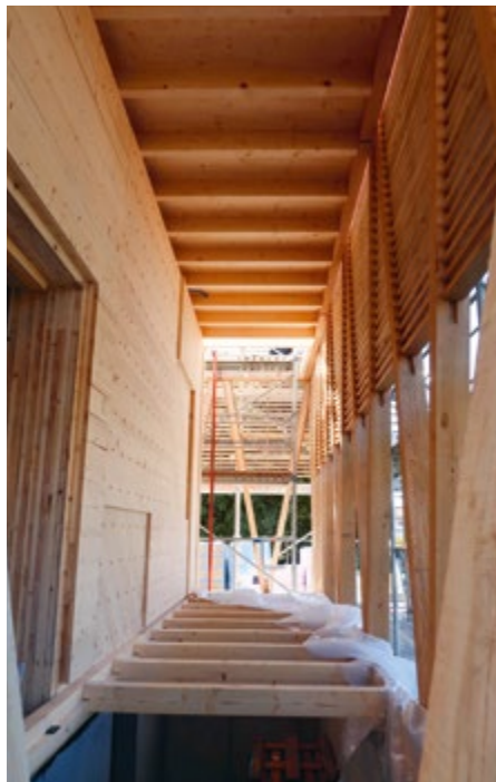
Dicke Truberholzwände für das Schaulager, Eichen als Wetterschutz.
