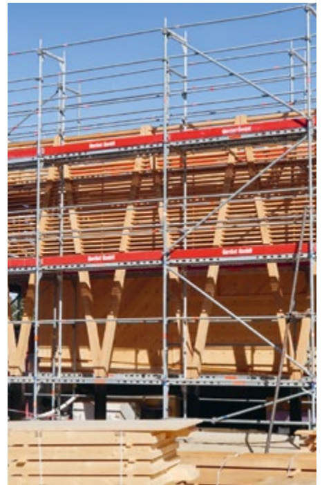
Die Eichen wurden als A-Buchstaben montiert, abgeleitet von AAAA Albert Anker à Anet (Ins)
