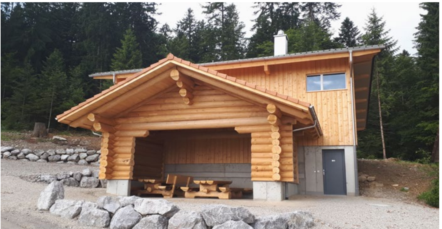
Der neue Werkhof oberhalb der Stafelalp
