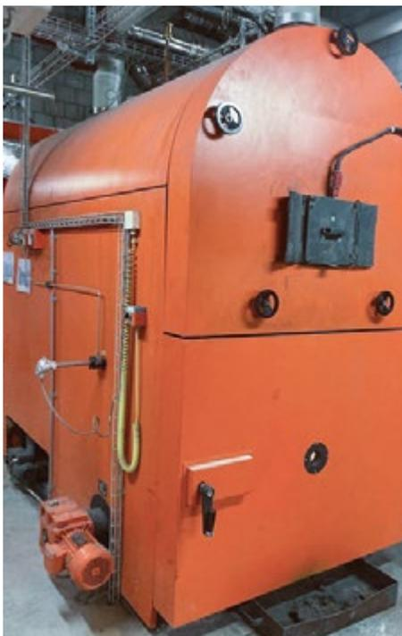
Die 550kW-Anlage versorgt 58 Haushalte mit Wärme.
