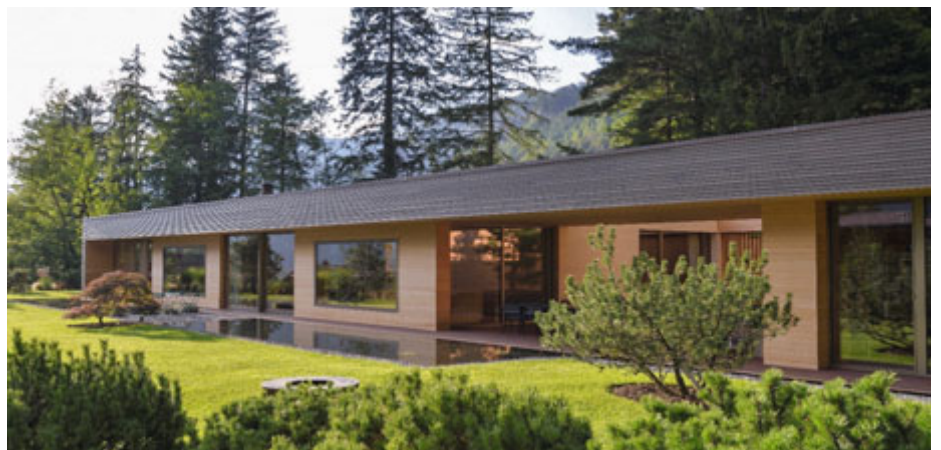
Vollständig in Holz gebaut, vorwiegend mit Schweizer Holz, mit vorgefertigten Holzelementen.
