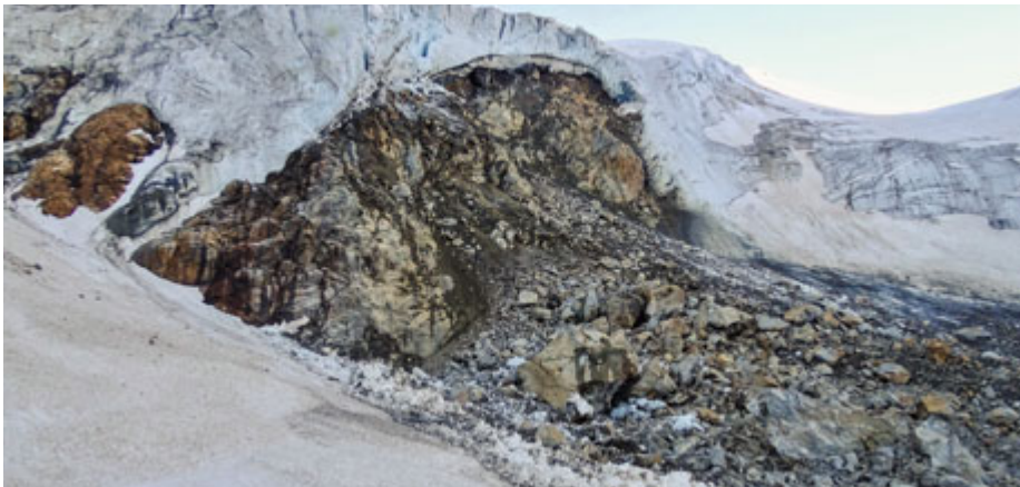
Felssturzablagerungen beim Steingletscher, Sustenpass der Abbrüche im Winter 2019/2020 (Aufnahme vom 02.06.2020, N. Hählen, Abteilung Naturgefahren).
